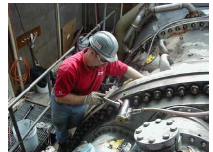
Bild 4: Unter Spannung: Der ITH-Schraubenspannzylinder im Gasturbinenbau.
